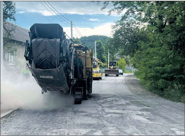
На автодорозі О-070701 Кольчино – Пузняківці підрядні організації виконують ямковий ремонт для лікві-
